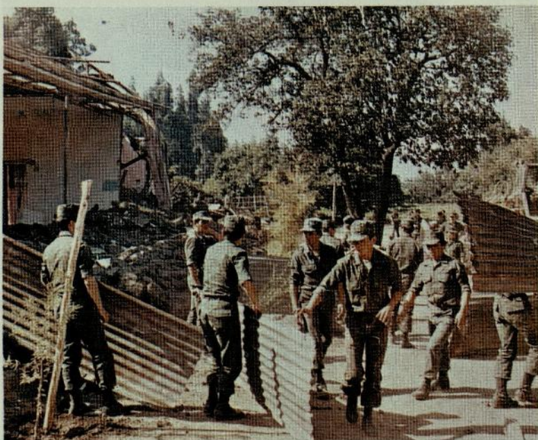
En la fotografía, soldados de la Escuela realizan trabajos en beneficio de los damnificados.
