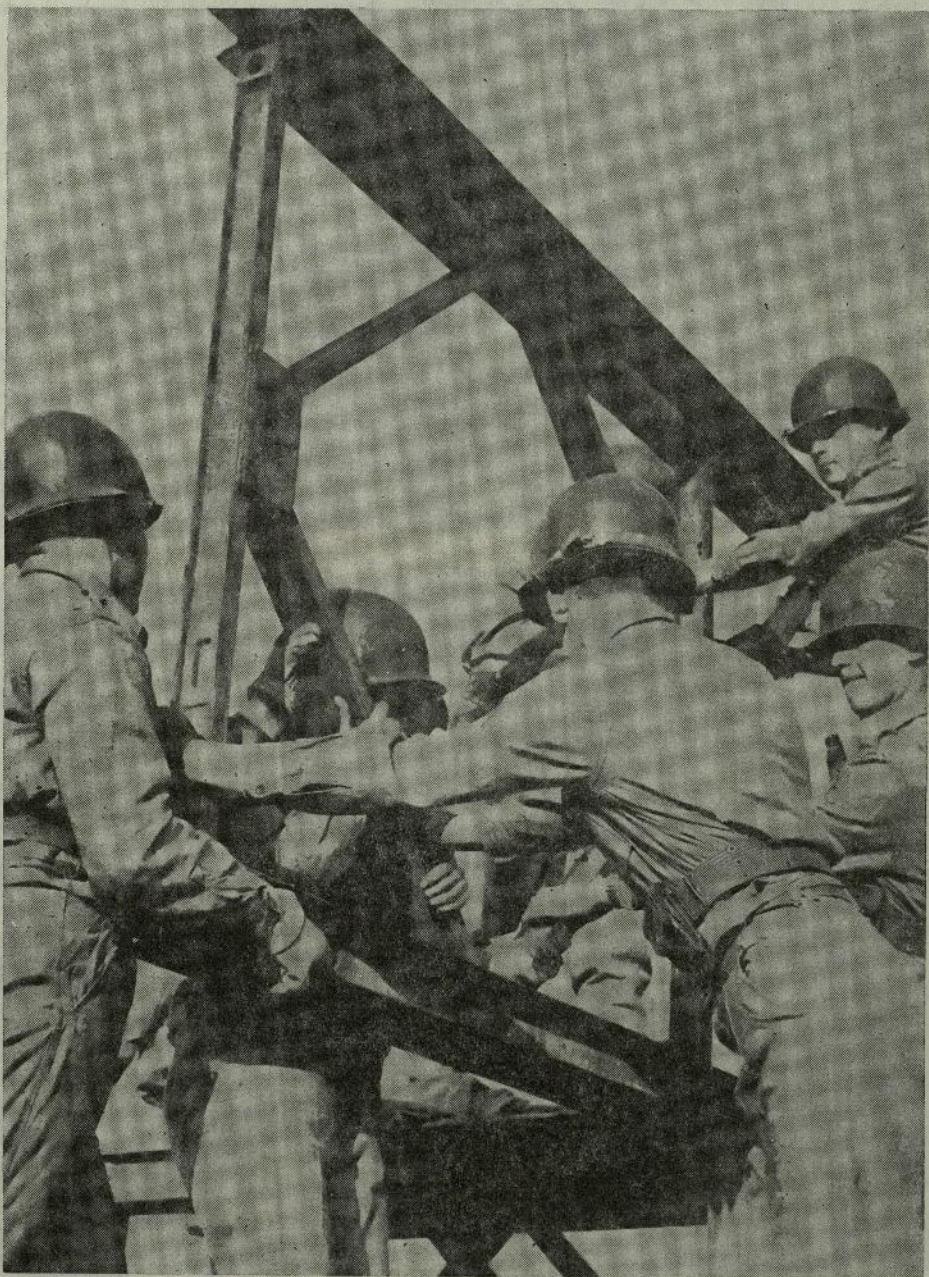
Los Alféreces son sometidos a duros esfuerzos durante el armado de un puente Bailey D-S en doble.
