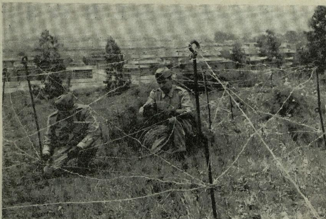
Alféreces Correa y Kossiel terminando la construcción de un paño de alambrada alta.
