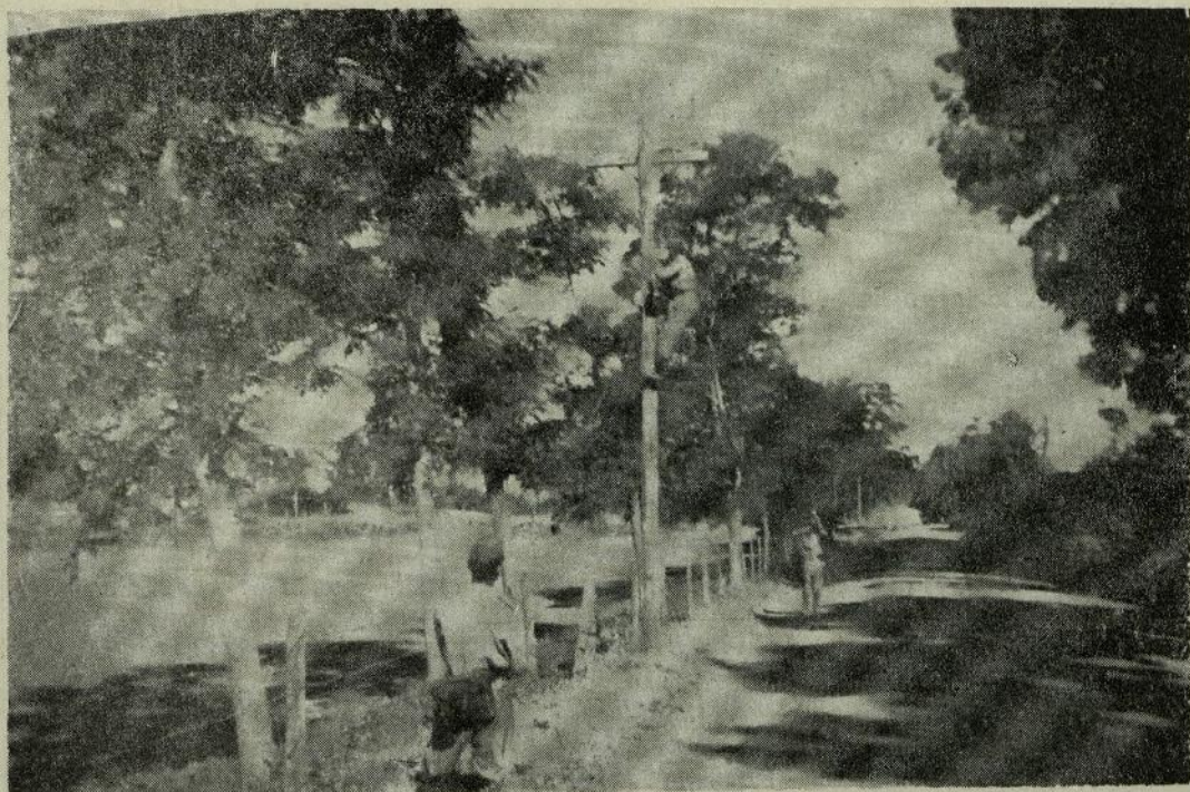
Una Cuadrilla de Construcción de Líneas tiende la troncal, que es la línea telefónica de mayor importancia en el tráfico alámbrico.
