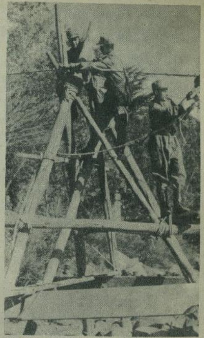
Alféreces zapadores construyendo un medio de paso en la Cordillera de los Andes.
